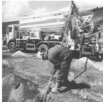
Figura 13. Carga de barrenos con camión mezclador de emulsiones.
